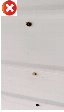
选择错误螺钉，发生锈蚀
